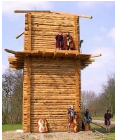
Wachttoren in aanbouw
